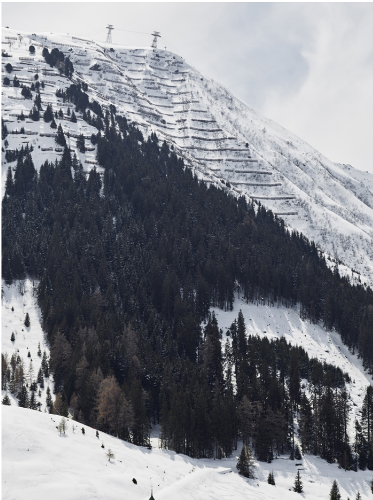
Georg Aerni Andermatt II, 2021 (9.4.2021, 13.20 Uhr) unten: Ausschnitt des oberen Bildbereichs Im April steht die Sonne am Mittag bereits so hoch am Himmel, dass sie in den steilen Nordhang des Gurschen einfällt und von den Lawinerverbauungen Schatten zeichnet.
